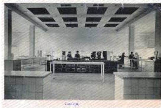
Hornos de Panadería y Cocinas
