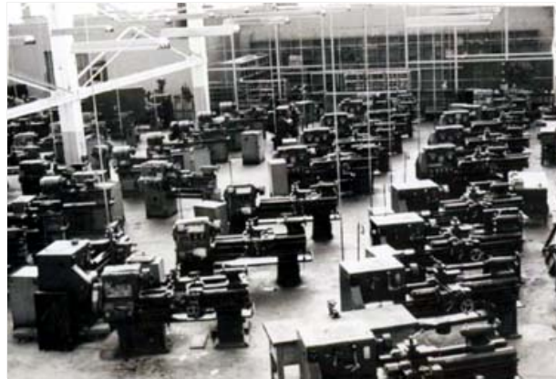
Equipamiento de los talleres politécnicos
