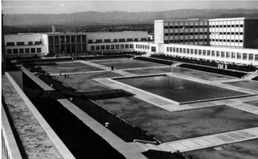
Patio central. Pérgola - Galería de comunicación entre Colegios. Al fondo el edificio de Servicios Comunes
