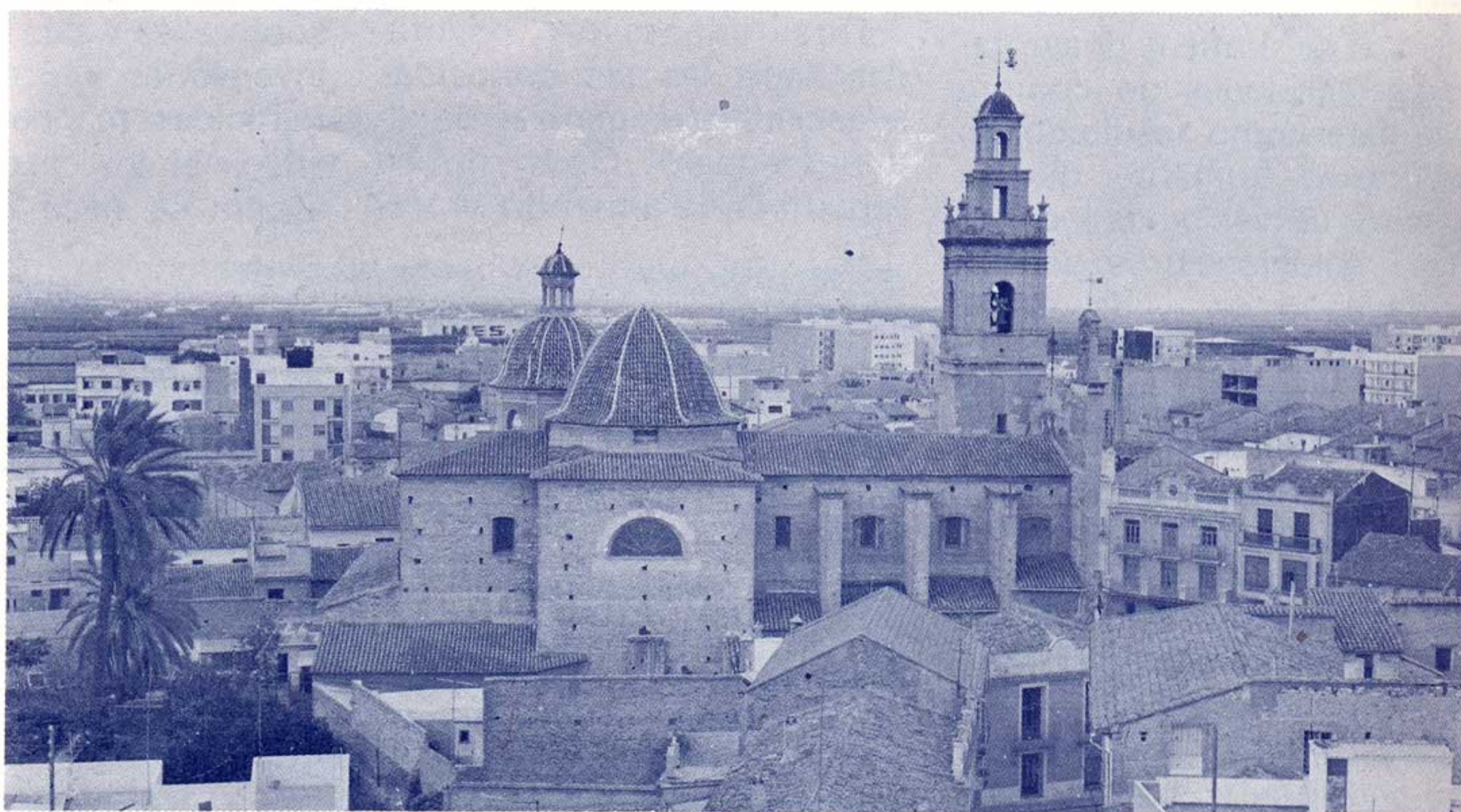
Un aspecto aéreo de la villa.
